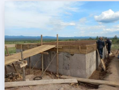
Vaciado de tanque de almacenamiento
