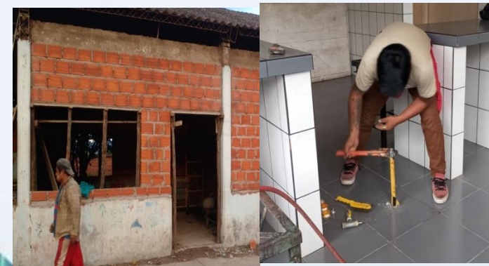
Construcción de aulas U.E. campo grande
