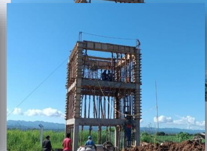
Construcción tanque elevado
