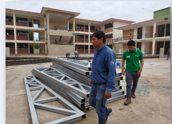
Inspección Técnica Ejecución Proyecto: Construcción Tinglado U.E. Octavio Campero Echazú.
