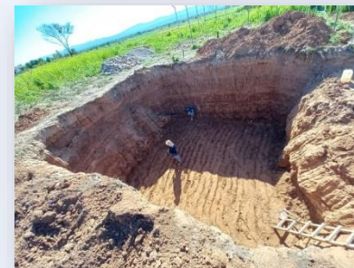
Excavación tanque enterrado
