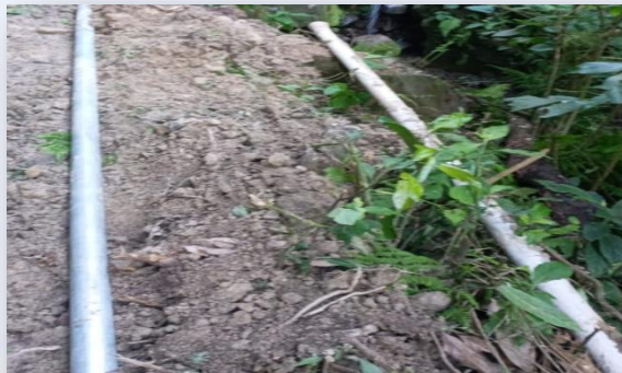
Mejoramiento sistema de agua potable comunidad santa rosa
