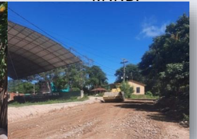
Compactado B° Juan Pablo II
