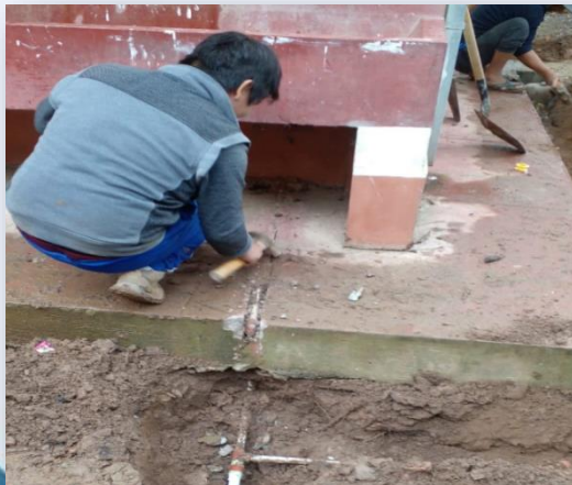
Trabajos de plomería
