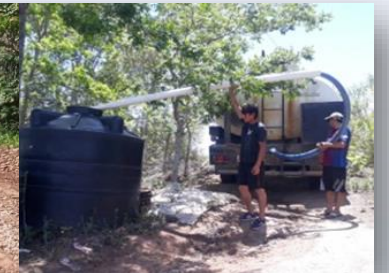
Dotación de agua Comunidad el Nueve
