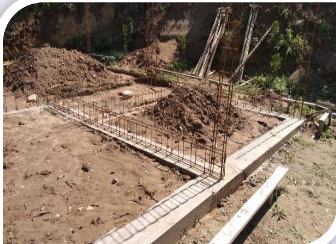
Inicio de proyecto de viviendas en el área rural – Gestión 2021
